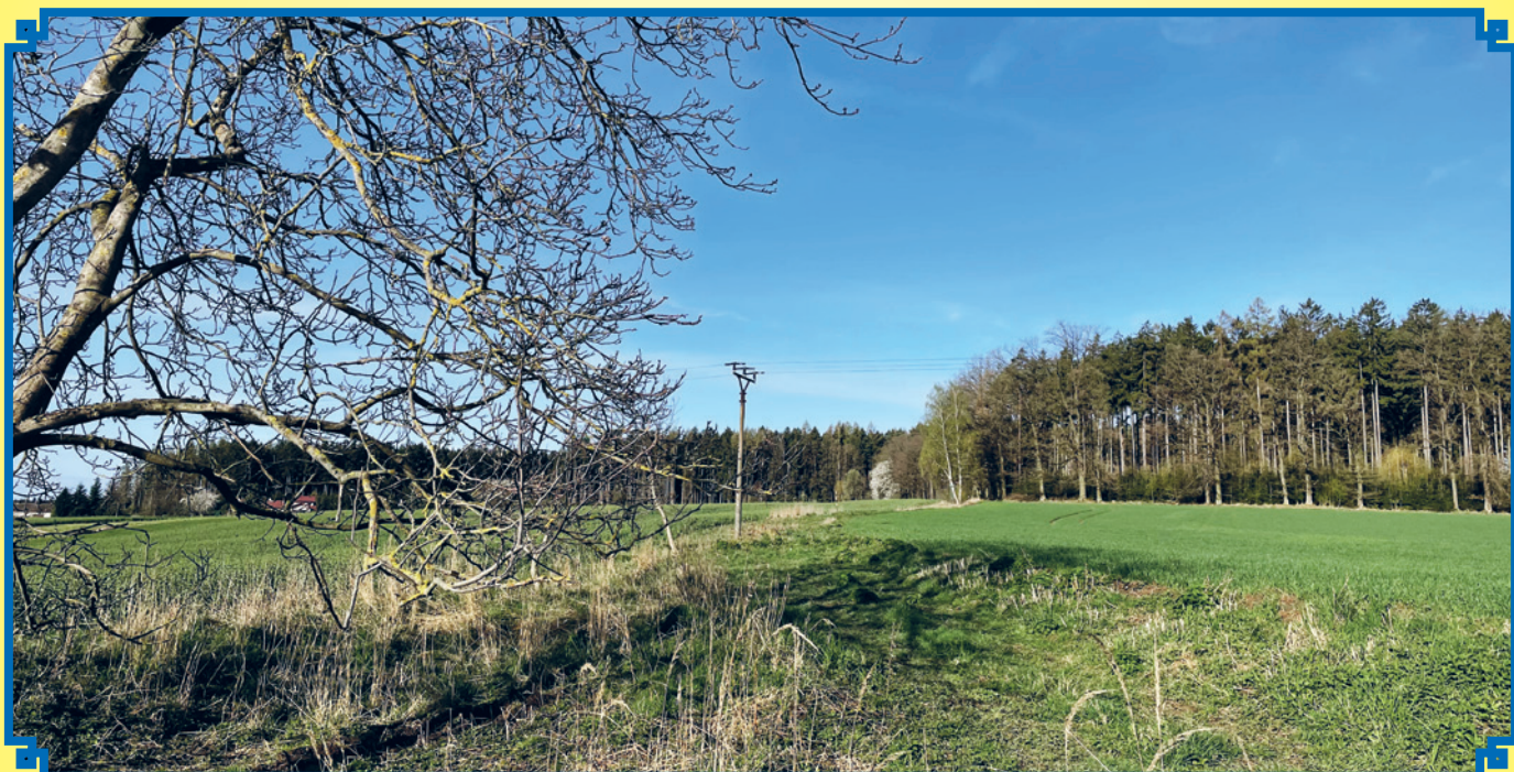
Odstranění náletů z cesty nad Radostovicemi
